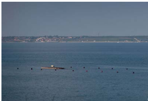
Рис. 1. Хвилелом для нового контейнерного терміналу в Одесі
