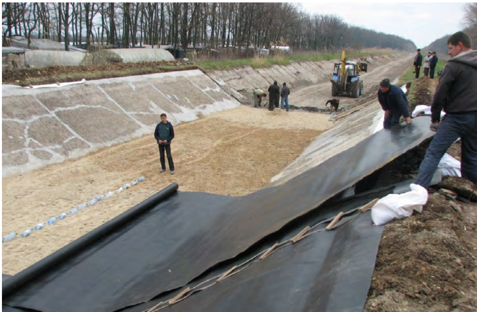
Рис. 1. Процес укладання геомембрани HDPE (поліетилену високої щільності Solmax 440-70007 t = 1 мм) на дослідно-виробничій ділянці Інгулецького магістрального каналу
