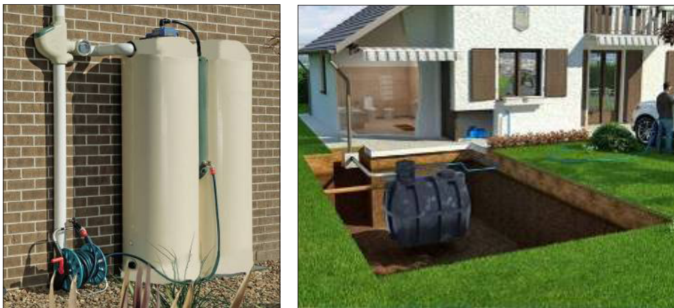
Рис. 3. Різні способи накопичення дощової води
