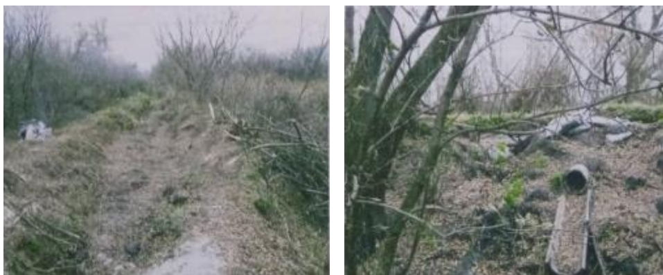
Рис. 3. Залишки зруйнованої системи скидання води на карти
