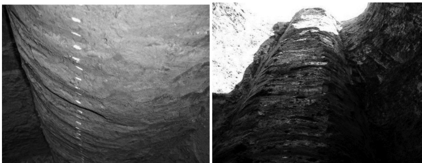
Рис. 5. Дослідження ґрунтоцементної палі за глибиною
