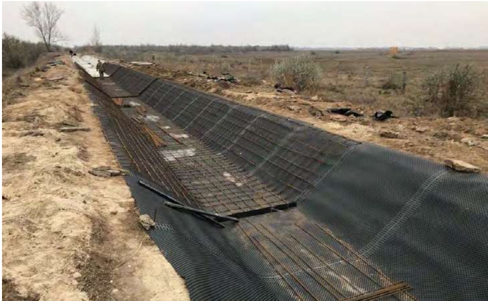
Рис. 2. Укладання шипоподібної мембрани Izolit та металевої арматури перед проведенням бетонних робіт на каналі Р-4-2 Інгулецької зрошувальної системи
